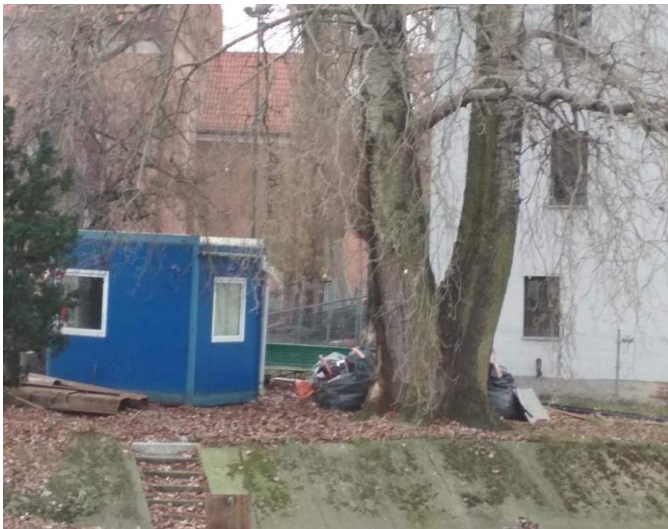
Zdj. 2. Kontener na placu budowy w strefie ochrony drzew, źródło: modrzew.org.pl
